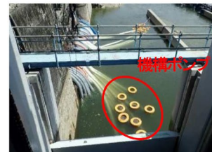
ポンプ車による緊急取水
